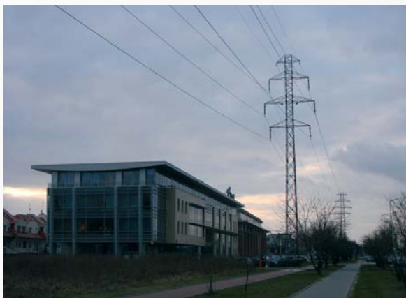
Rys. Z2-2. Przykład usytuowania budynku biurowego w sąsiedztwie linii elektroenergetycznej 110 kV [fot. Autorzy]
