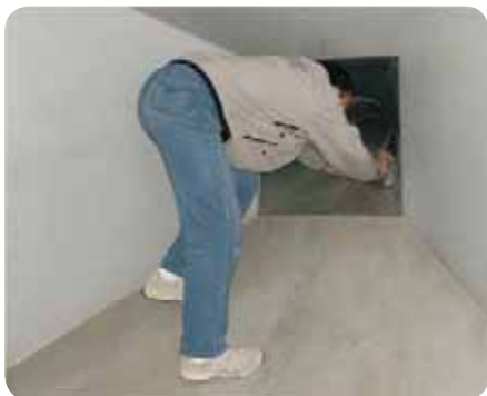
Fot. 1. Czyszczenie środkiem konserwującym w kanale wentylacyjnym
