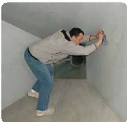
Fot. 4. Wcieranie środka konserwacyjnego w powierzchnię ściany – 1
