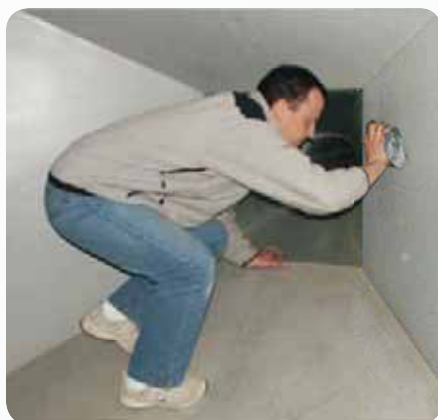
Fot. 5. Wcieranie środka konserwacyjnego w powierzchnię ściany – 2
