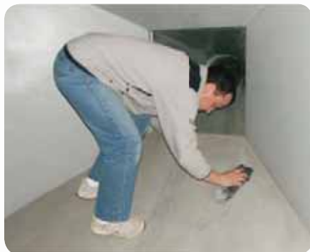
Fot. 2. Wcieranie środka konserwacyjnego w powierzchnię podłogi – 1
