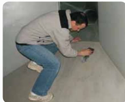
Fot. 3. Wcieranie środka konserwacyjnego w powierzchnię podłogi – 2
