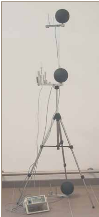
Rys. 4. Trzy zestawy czujników (por. rys. 3.) do pomiaru wartości parametrów powietrza w warunkach niejednorodnych
