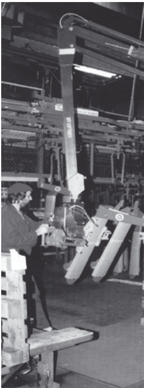
Fot. 2. Przykład zmechanizowania przenoszenia dużych i ciężkich części maszyn
