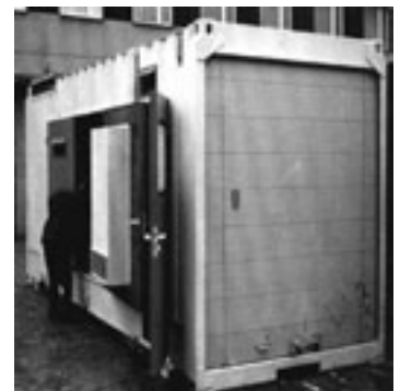
Obudowa dźwiękochłonna-izolacyjna agregatu prądotwórczego 0,5 MW – zaadaptowany kontener obudowany elementami dźwiękochłonnymi z blachy trapezowej o grubości 3 mm
